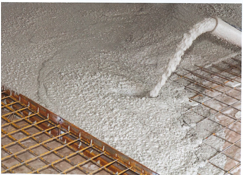
De vloer is in vijf testvakken verdeeld met elk een ander type wapening of beton.
