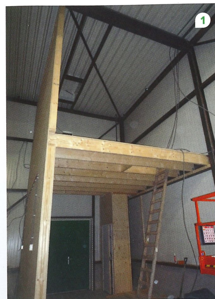
1 // Een verdiepingvloer is optioneel. In de eerste unit is onder de verdiepingvloer een gemeenschappelijke installatieruimte met eigen toegangsdeur gepland. 2 // Elke travee heeft een loopdeur en een bedrijfsdeur. 3 // Het handmatig openen van de bedrijfsdeuren gaat vederlicht dankzij strakke veren in het systeem. 4 // Naast het gebouw wordt geobeton (deels met en deels zonder wapening) getest op sterkte, inzouten, krimp en scheurvorming. 5 // De staalverbindingen zijn uit milieuoverwegingen niet gelast. 6 // De bedrijfshal kan per travee worden verhuurd en krijgt dan een scheidingswand van FSC-hout.
